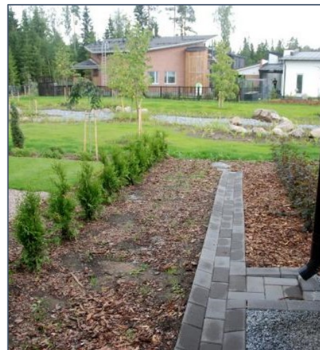
Esimerkkikuva hulevesien johtamisesta © Tampereen kaupunki
